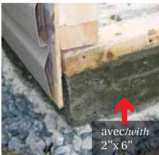
Pour la préparation des formes, utiliser des planches d'au moins 2" x 6" (5 1/2" de hauteur) pour éviter les bavures de ciment à la base. Celles-ci peuvent nuire à la pose du revêtement au bas des murs.
