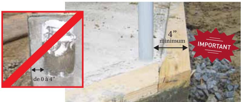
Ne pas installer de tuyaux ou de fils à moins de **4"** du rebord du plancher de béton.
