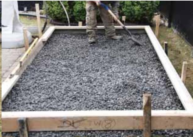
Couvrir le fond d'une toile en géotextile. Remplir ensuite de pierre 3/4" net jusqu'au niveau du sol fini ou du trottoir. L'emplacement est maintenant prêt à recevoir les formes.
